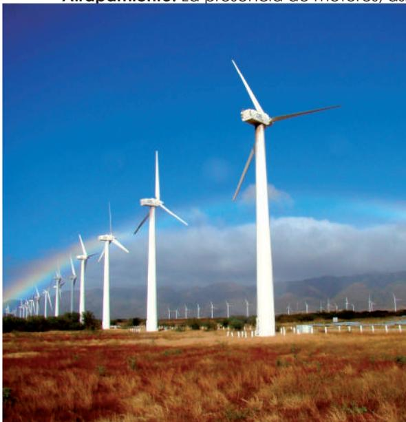
como los mismos mecanismos de rotación de la góndola sobre del poste, del buje y de las palas, tienen el potencial de provocar atrapamientos de partes del cuerpo de las personas. Este tipo de alto riesgo de requiere operaciones de desconexión y bloqueo mecánico. Con etiquetado y candado, que son obligatorias por procedimiento, para acceder a la góndola. El riesgo de quedar atrapado es trascendente en el
